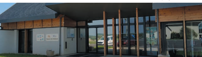
Espace des Habitants à Villemer
