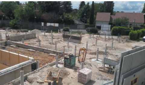
Chantier du Centre aquatique
