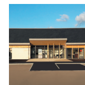
Espace des Habitants à Villemer
