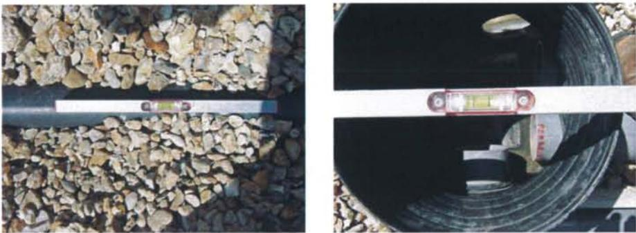
**Photos : Mesure de la pente sur un drain d'épandage et de l'horizontalité sur un regard de visite**
