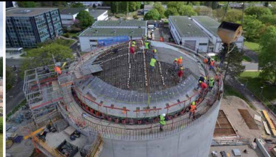
Unique au monde, une maquette d'enceinte d'un bâtiment réacteur de 1 300 MW, sans équipement nucléaire, est actuellement en construction à EDF Lab Les Renardières.
